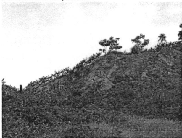
Foto N° 1 – Taludes con alta pendiente. No se ejecutó paisajística y geomorfológica.
